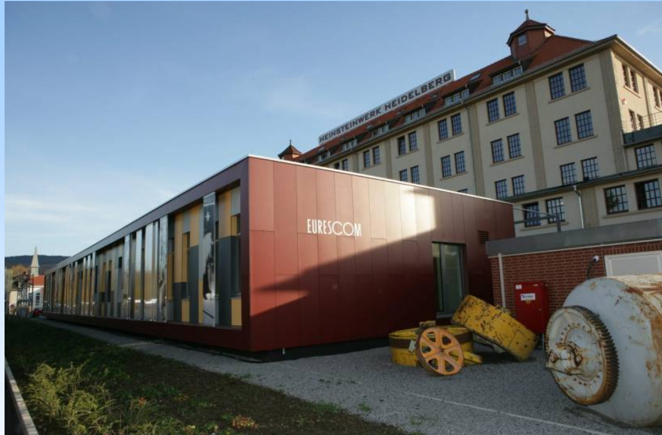
被动式房屋标准的办公建筑 (前) 经改造翻修的工业建筑 (后)
