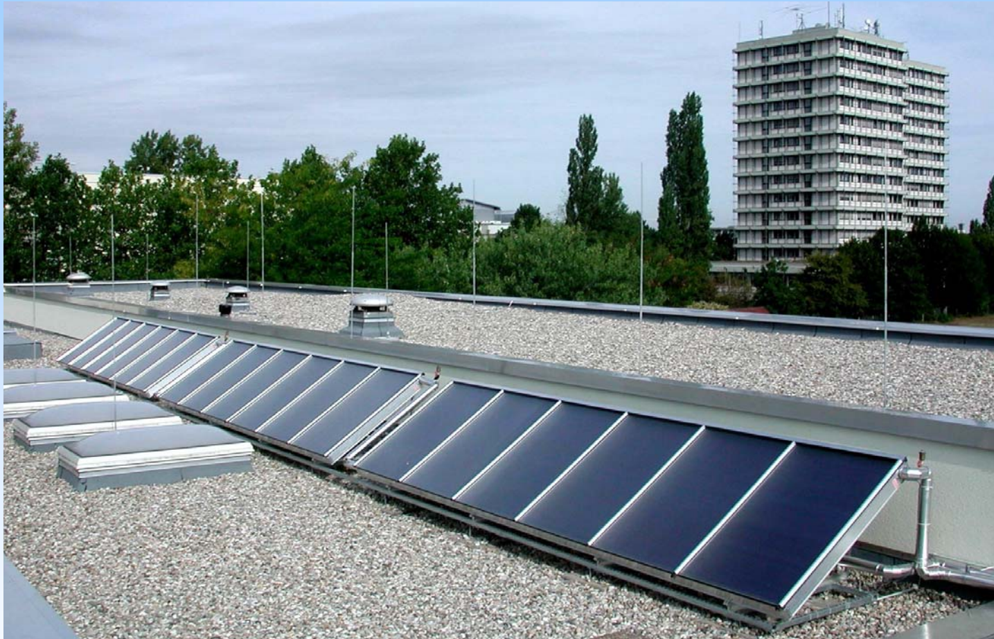
玛丽保姆学校太阳能供热系统 厨房用热水
