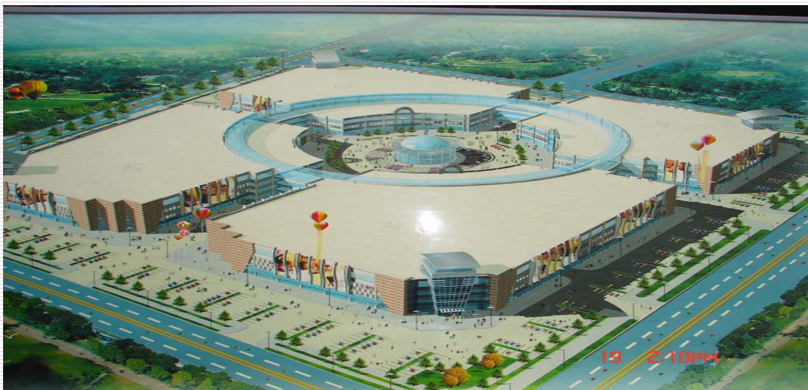
全钢架结构大型商用建筑群—乌鲁木齐美居物流园
