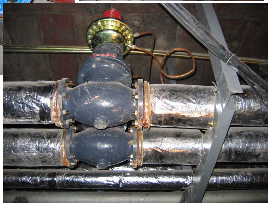
平衡阀、压差控制阀、恒温阀 安装图
