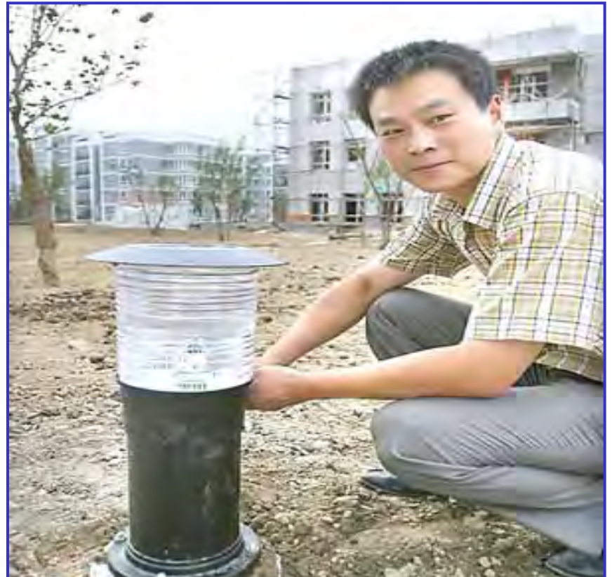
乌鲁木齐市“华美·文轩”小区的物业管理人员正在小区安装太阳能照明灯 Installation der Solarbeleuchtungen im Wohnviertel “HuaMei-WenXuan” in Urumqi
